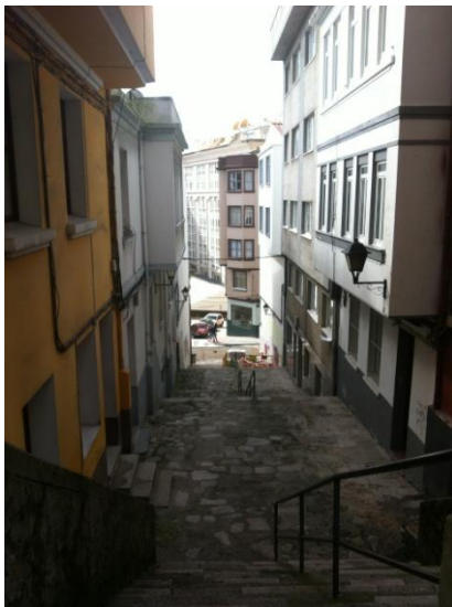
Fig. 10. Escalinata desde la calle Ángel Rebollo. Se aprecian dónde están situados los accesos a los inmuebles, y el tipo de pavimentación rústica.
