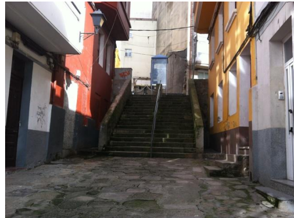
Fig. 9. El último tramo es el mayor; es necesario reformar estas escaleras para situar un descansillo en medio, y que cumpla la normativa. En esta imagen se aprecian los pasillos dejados para dar ventilación a las ventanas de los bajos de viviendas, si bien las ventanas del bajo de la izquierda se encuentran tapiadas.
