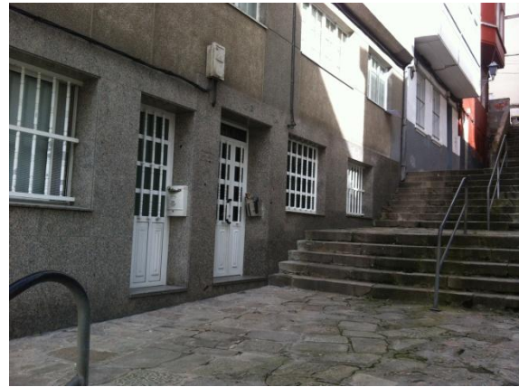
Fig. 7. En el donde se situará el primer descansillo y el inicio del segundo tramo, existen entradas a viviendas y ventanas.
