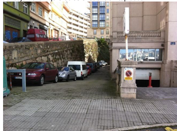
Fig. 11. Talud de la rampa del Matadero, donde situamos la primera actuación complementaria propuesta. Para el acceso al ascensor, sería necesario acondicionar un acceso peatonal. El ascensor se situaría al final de la línea. Hay que tener en cuenta que en la actualidad pertenece a la parcela del hotel.
