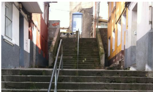
Fig 3. Final de la calle, donde se aprecia el estrechamiento de las escaleras causado por los dos edificios a los lados
